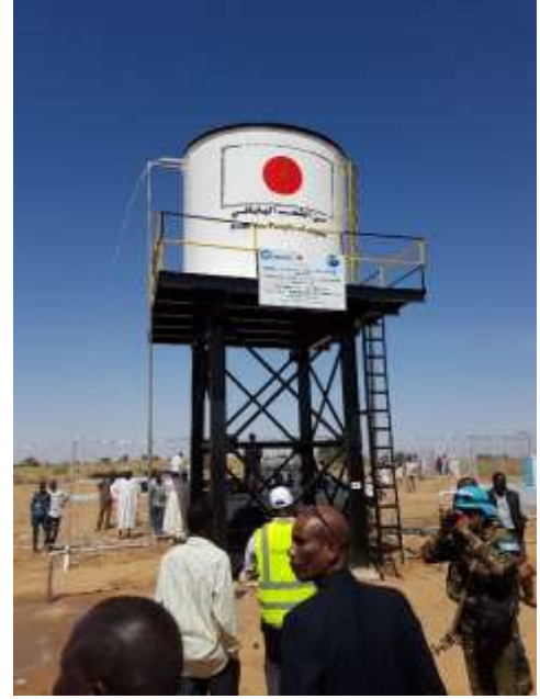
محطة المياه التي تم تشييدها بمنطقة طنجكي
